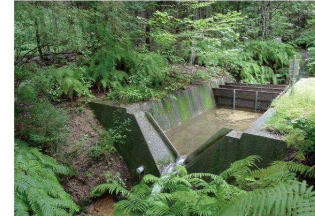
写真1 量水堰（大篠原流域）。プール部分の水位を計測し、流出水量へと換算する。
