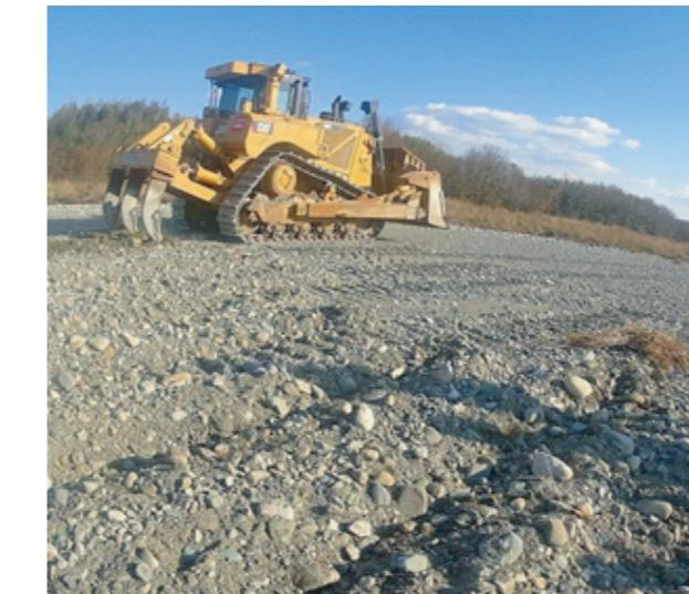
写真1 愛知川の固定化砂州を河床耕耘する様子
