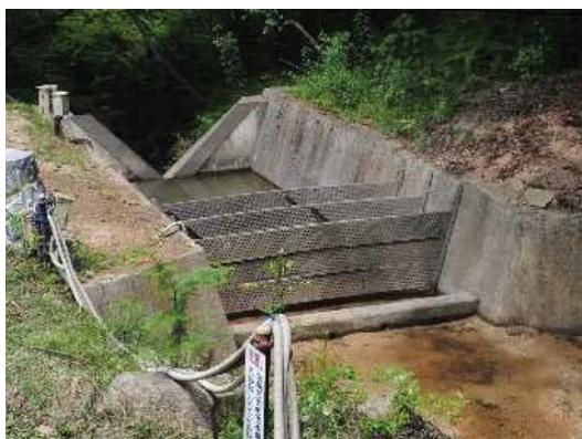
図 3-4 森林渓流に設けた量水堰（左：通常の流量の時、右：2017 年台風 21 号通過直後）
