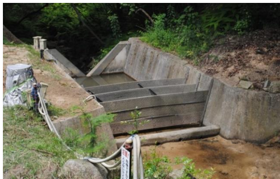
図 3-5 土砂流出調査地(野洲市大篠原)
