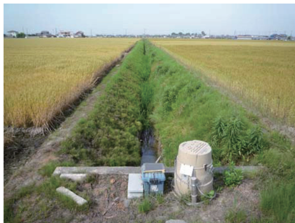
図3 農業排水路 A（守山市）
