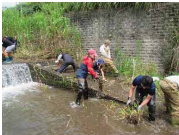
図5-3 魚道に堆積した土砂の除去作業
