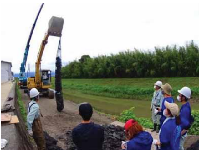
図5-2 中ノ池川におけるバープ工の設置作業
