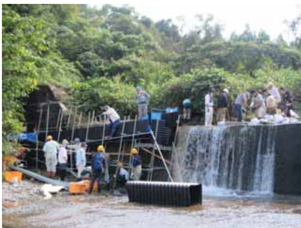
図 5-5 堰堤への仮設魚道設置作業
