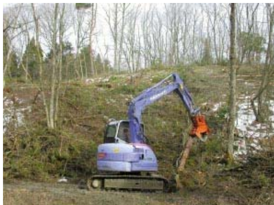
写真2 重機による材の搬出(2003年12月26日撮影)
