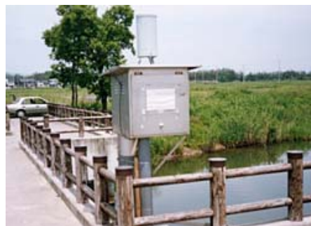
中央部に設置した水位計と雨量計 (1997年6月1日撮影)
