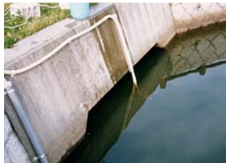
流出部に設置した流速計 (1997年6月30日撮影)
