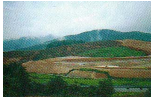
造成中のびわ湖東部工業団地
