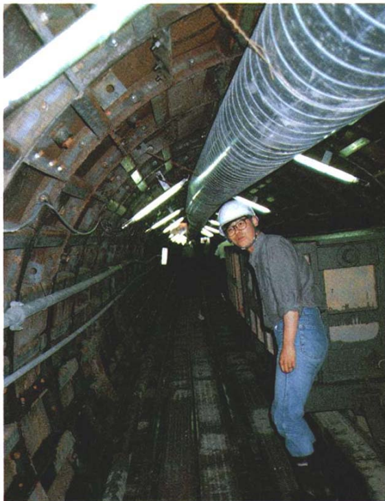
東北部浄化センター流入管渠
