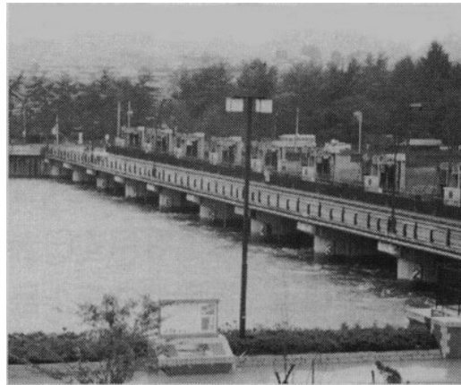
ゲートを全開して放流(瀬田洗堰) (写真提供:琵琶湖工事事務所)
