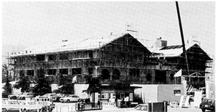
建設中の琵琶湖研究所
