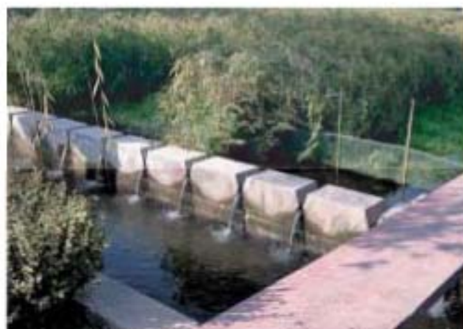
写真 撫仙湖流入河川に設置された水質浄化施設 （河川利用水を水草帯に通して浄化。写真は、浄化された水が流出する様子）
