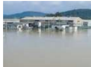
台風21号による浸水 (2017年10月)
